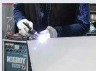
アルゴン溶接
